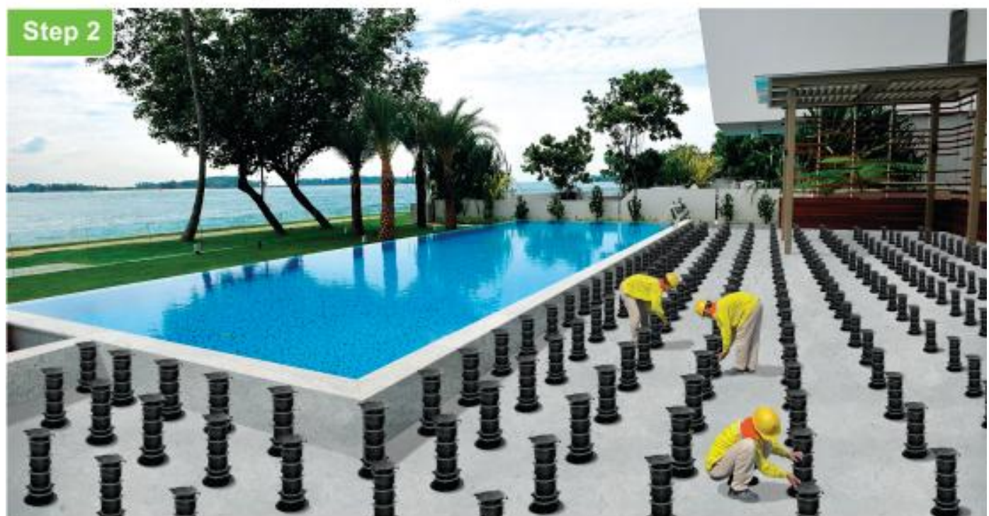
Step 2 Put VersiJack on the slab Bước 2 Đánh dấu vị trí và đặt trụ nâng sàn VersiJack có khoảng cách bằng nhau
