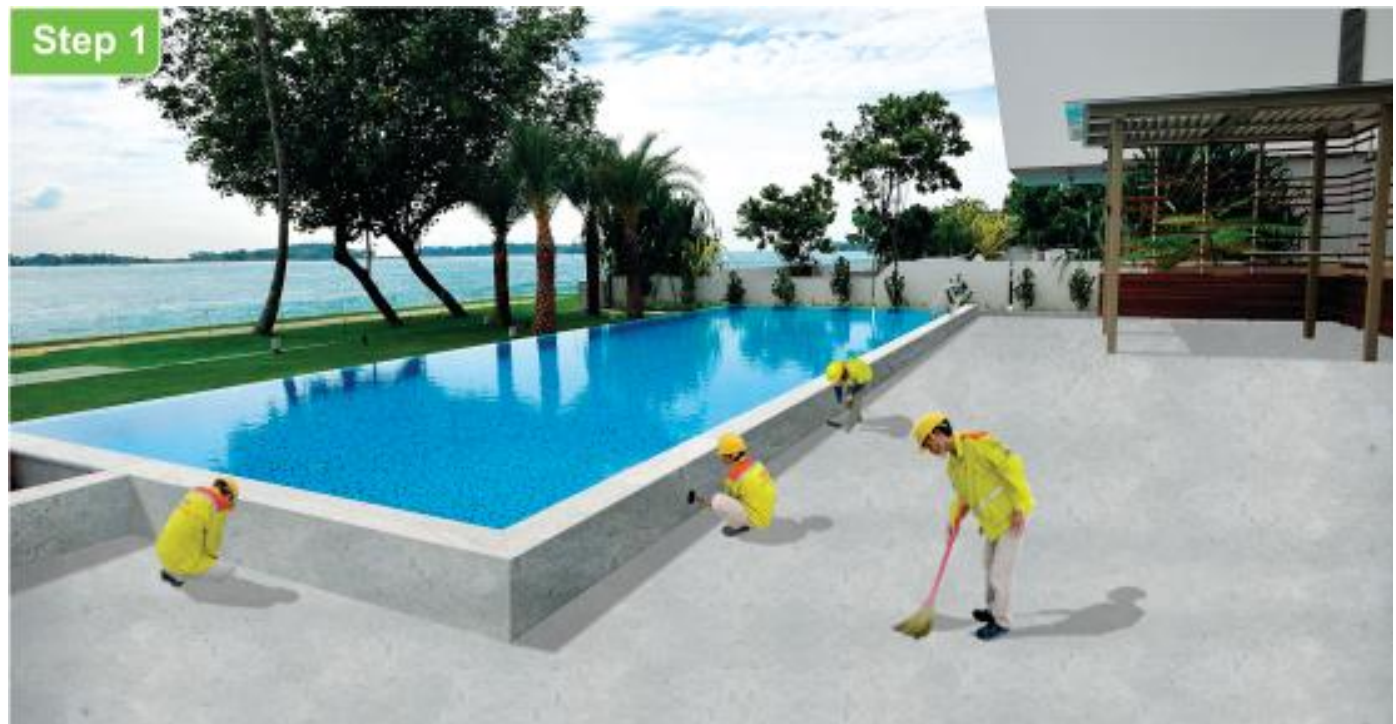
Step 1 Cleanning the surface Bước 1 Chuẩn bị mặt bằng đã được vệ sinh sạch sẽ
